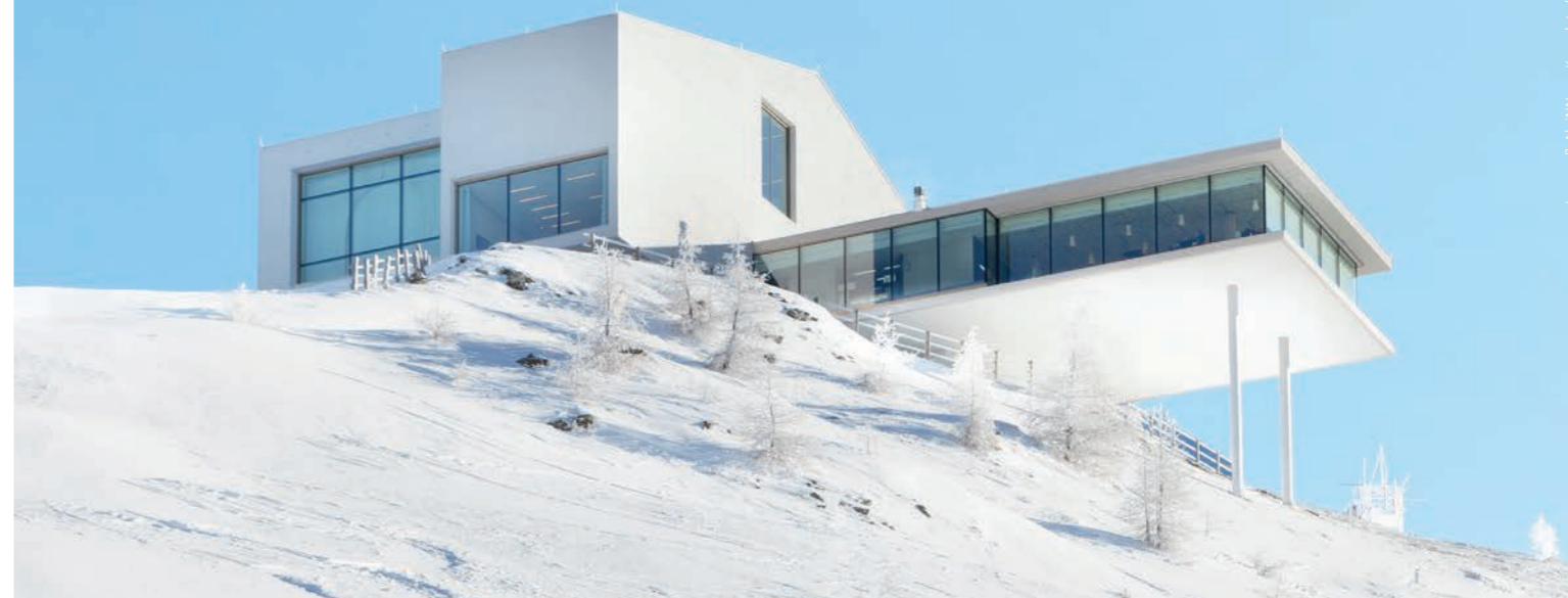
Fassaden Fenster & Türen Glas & Metall
